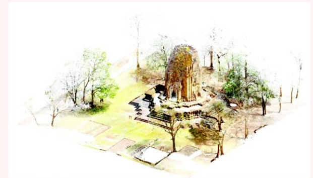
ใช้เทคโนโลยีสแกนวัตถุ 3 มิติด้วยแสงเลเซอร์ประเมินเสถียรภาพปราสาทศรีเทพ
