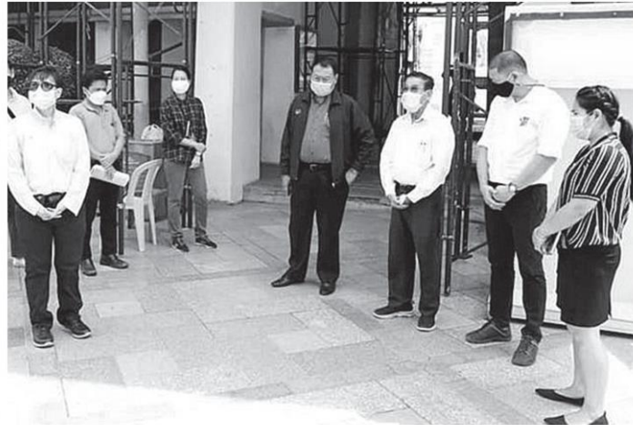
ประทีป เฟ็งตะโก อธิบดีกรมศิลปากร ประชุมคณะกรรมการและ ตรวจการจ้างงาน (ประจำงวดที่ 1) ในโครงการบูรณปฏิสังขรณ์พระระเบียง และ พระวิหารคด วัดสุทัศนเทพวรารามราชวรมหาวิหาร เมื่อวันก่อน.
