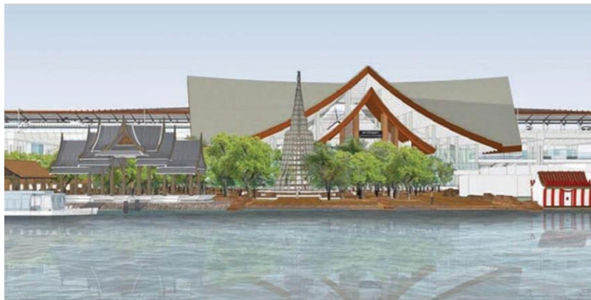
ภาพสถานีอยุธยา ที่การรถไฟฯ ปรับแบบใหม่ เป็นอาคารใหญ่ คร่อมสถานีเดิม สูง 45 เมตร กรมศิลปากรเห็นว่า จะกระทบต่อโบราณสถานและมรดกโลก (ปัจจุบันการรถไฟฯ ยกเลิกรูปแบบนี้แล้ว)
