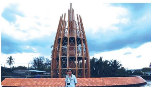
สถาปัตยกรรมหอเตือนภัย
